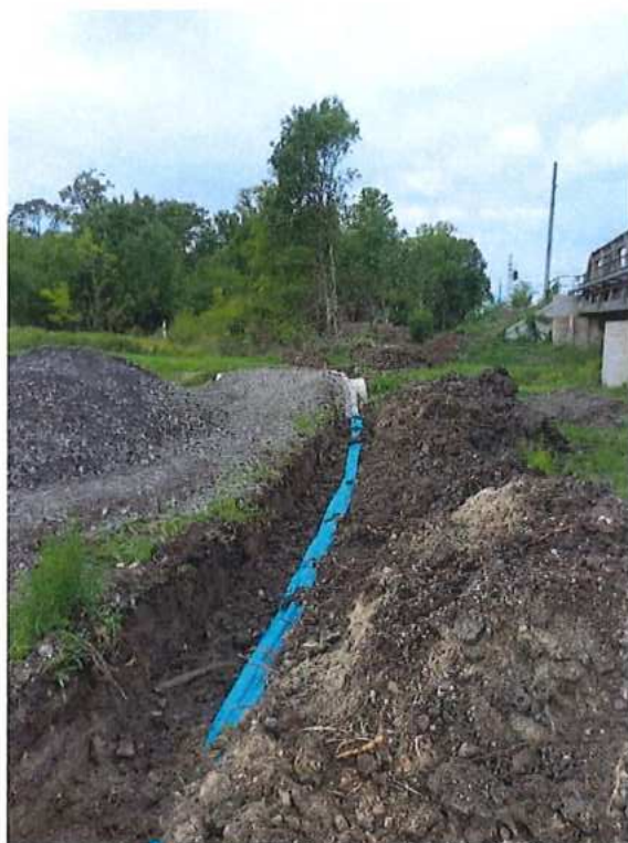
Prekládka káblov pri SO 12-33-02 v nžkm 73,489 (ev. km 73,466)
