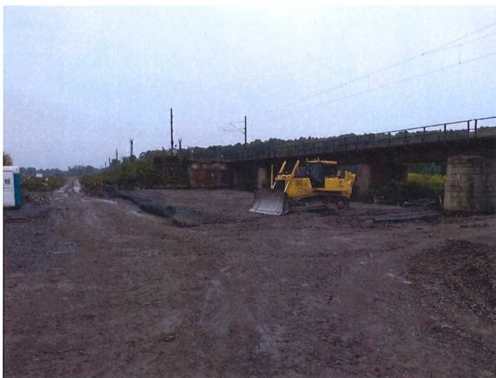
Výmena podložia pod násyp koľaj č.2 pri SO 12-33-04
