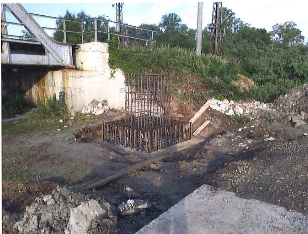
Armovanie základov dočasných opôr pri moste v nžkm 73,489 (ev. km 73,466)
