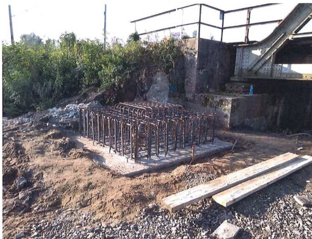
Armovanie základov dočasných opôr pri moste v nžkm 73,232 (ev. km 73,210)
